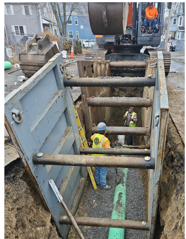
Instalación de tubería de agua residual (agua negra) en Tenney St
