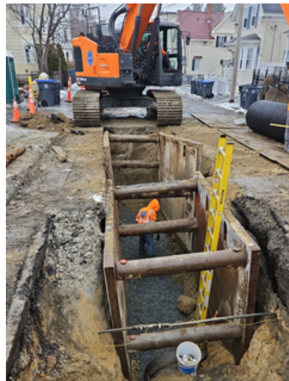
Instalación de tubería de drenaje en Tenney St
